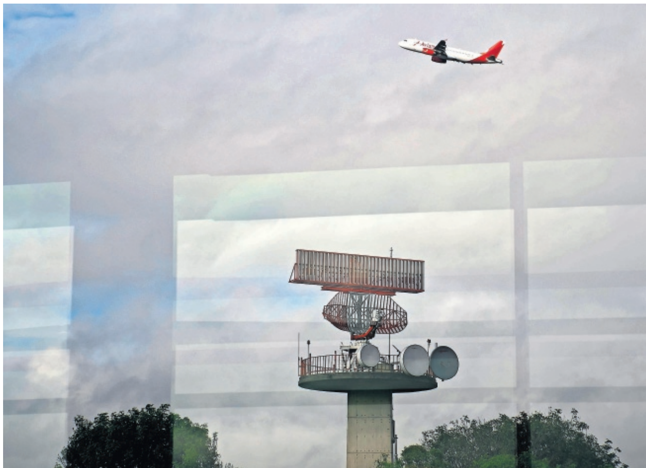
Radar de control aéreo del aeropuerto de El Dorado de Bogotá. FOTOS: Á RUIZ DEL ÁRBOL
